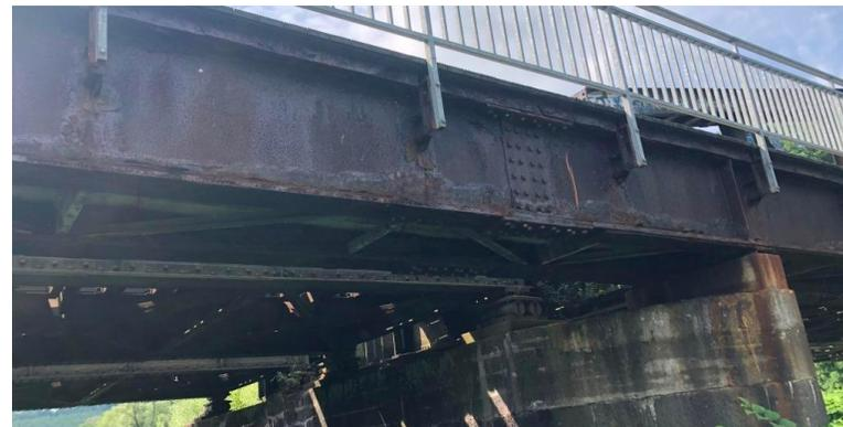
Seitenansicht auf korrodierte Längsträger
