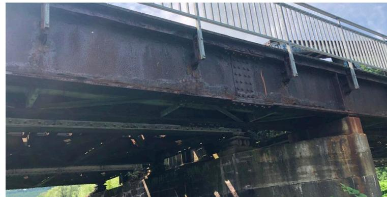
Seitenansicht auf korrodierte Längsträger
