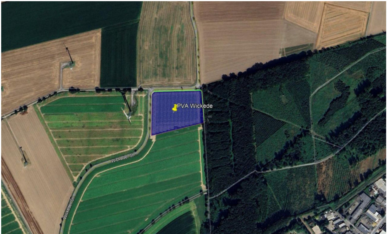
Bild 2.2: Luftbild der PV-Anlage (Quelle: Google Earth / SolPEG)
