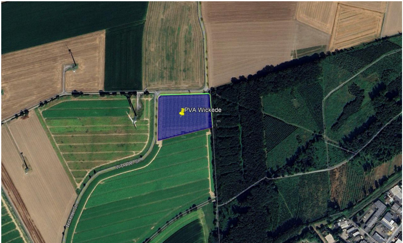
Bild 2.2: Luftbild der PV-Anlage (Quelle: Google Earth / SolPEG)
