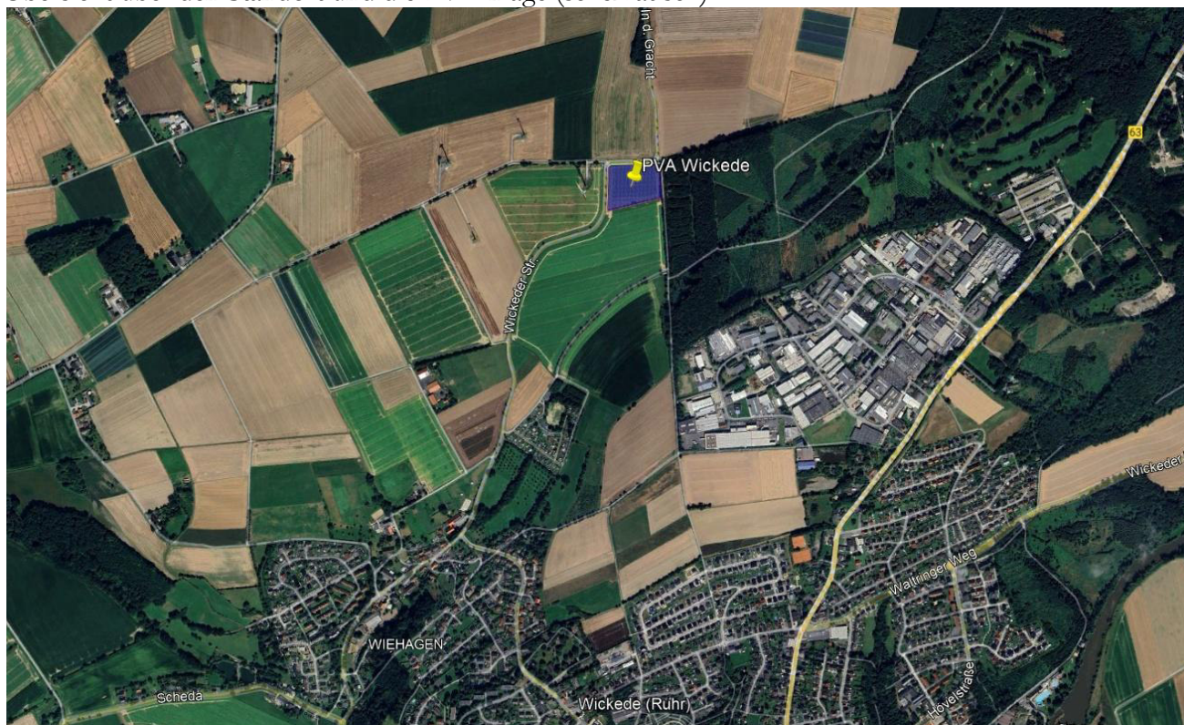
Bild 2.1: Luftbild der PV-Anlage (Quelle: Google Earth / SolPEG)
