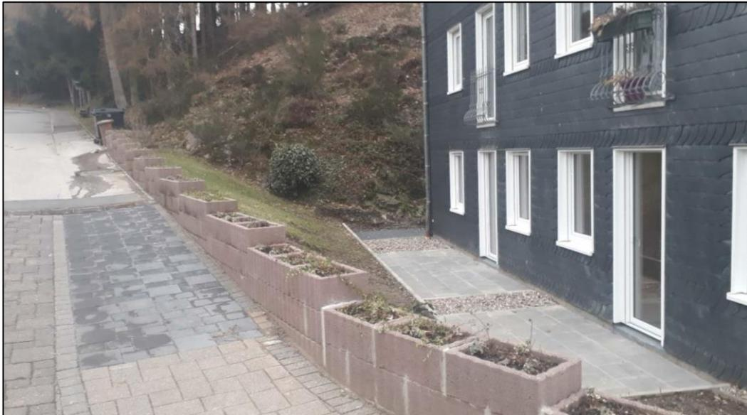
Abb. 5-1: Pflanzmauern zur Lenkung von Oberflächenabfluss (Beispiel)
