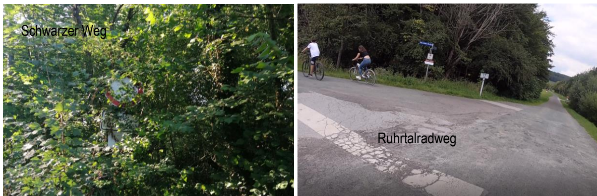
Abbildung 22: Fehlende Wegweisung / Beschilderung: Schwarzer Weg und Ruhrtalradweg
