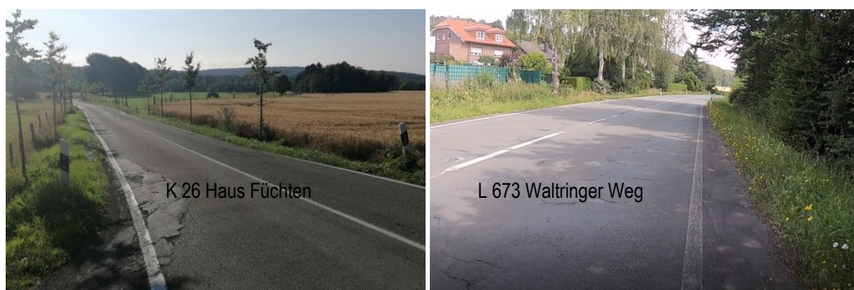
Abbildung 16: Fehlende Radverkehrsführung: K 26 (Haus Füchten) und L 673 (Waltringer Weg)
