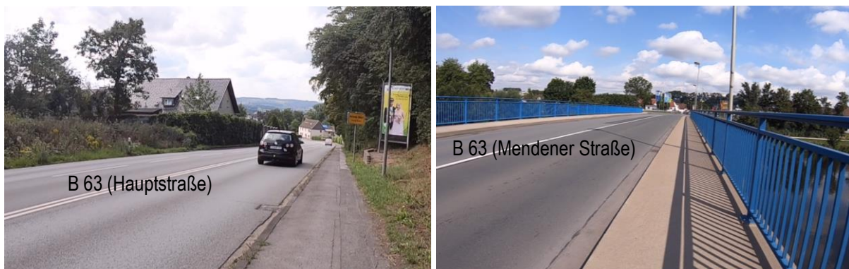
Abbildung 17: Fehlende Radverkehrsführung: B 63 (Hauptstraße) und B 63 (Mendener Straße)
